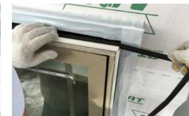
窓回りは透湿防水シートを巻き込み、さらに専用の気密材を回して雨仕舞いを行う
