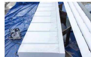
『DAN壁』裏面にCLTの接合金物があたる部分(写真では右端部分)は、EPSを欠き込んで施工(等間隔に入っている溝は排水用)
