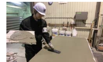
左官職人の技が映える『DAN壁』の生産現場。旭川第二工場で新しい生産ラインが稼働すれば、生産能力は現在の3倍になる
