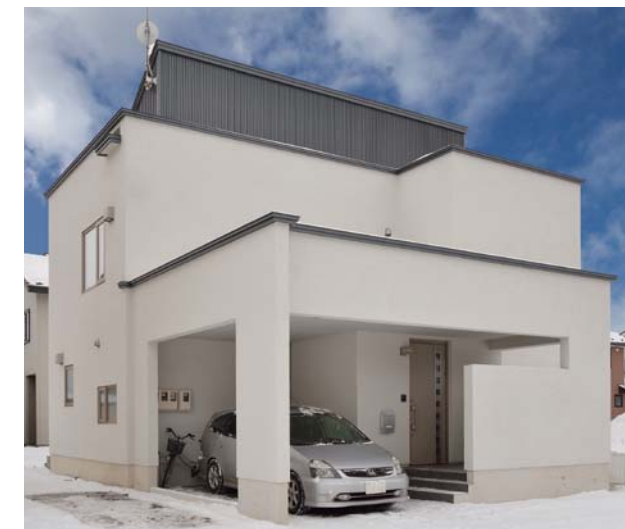
外壁260mm断熱(うち『DAN壁』155mm)で施工された釧路ゼロ・エネルギー・ハウス
