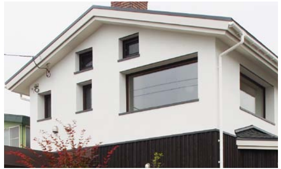
窓を室内側に取り付けた外壁 400 mm断熱の住宅。窓が奥まって見えることでRC住宅のような表情になる
