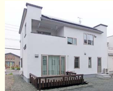
「DAN壁」を採用した釧路ゼロエネハウスの外観
