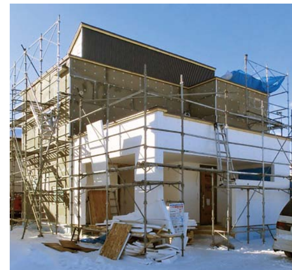
断熱施工中の躯体。建物一体となるカーポート回りも『DAN壁』で仕上げる
