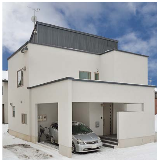
ゼロ・エネルギーハウスの外観。ガルバリウム鋼板で仕上げた勾配屋根部分に太陽光発電パネルが設置されている
