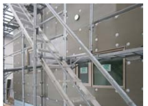
『DAN壁』による付加断熱部分は、最初に105mm厚の製品を仮留めしておき(写真左)、その上から200mmのビス・ワッシャーで50mm厚の製品を留め付ける(写真右)
