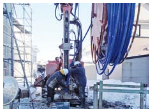
深さ81mの穴に地中熱を採熱するUチューブを入れているところ
