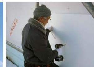
『DAN壁』による付加断熱部分は、最初に105mm厚の製品を仮留めしておき(写真左)、その上から200mmのビス・ワッシャーで50mm厚の製品を留め付ける(写真右)
