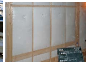
軸間にはアクリアブロー105mmを吹込み
