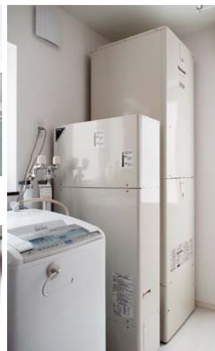
ユーティリティに設置された地中熱ヒートポンプ本体とエコキュート
