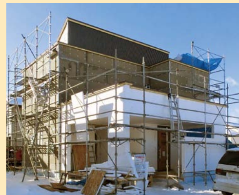
建設中の現場。外壁にはDAN壁が施工されている
