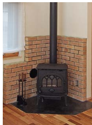
背面のレンガと外壁の間から給気するように工夫した薪ストーブの設置例。煙突もまっすぐ屋根まで伸ばしている
