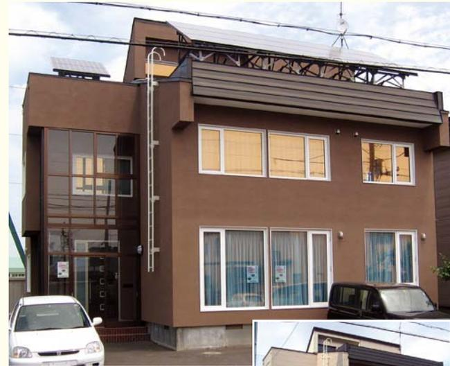
「DAN壁」を施工し、屋根に太陽光発電パネルを設置した改修後の外観(上)と改修前の外観(右)
