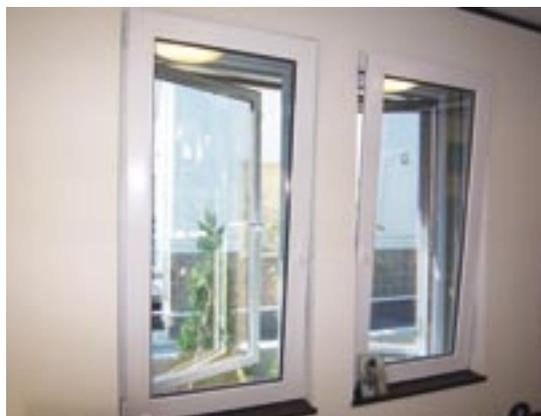
300 mm断熱の外壁の室内側に内倒し・内開きの窓、屋外側に外開きの窓を取り付けた住宅。この後、窓と窓の間にブラインドを設置した
