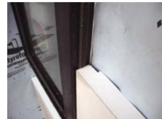
EPS断熱材の厚さが50mmなのでサッシとの取り合いも特別な工夫なく納めることができる
