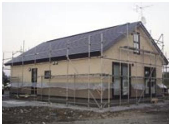
ツートーンのトップコートで仕上げた付加断熱パネル試験施工の住宅。湿式外装ならではのテクスチャーは他の外装材にはない大きな魅力
