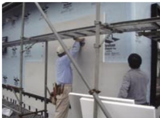
付加断熱パネルは横使いで割り付け、プラスチックワッシャーをビス留めして固定する
