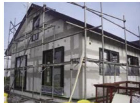
パネルのジョイント部分はグラスファイバーメッシュを載せてからベースコートを塗って処理している
