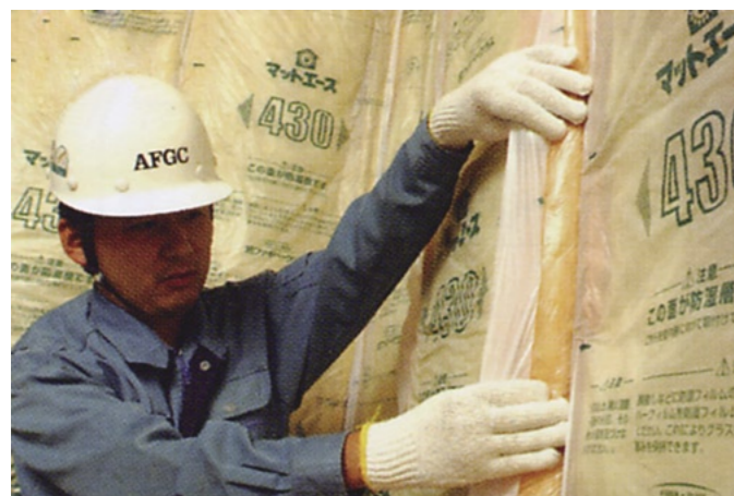
関東以南でよく使われている耳付きグラスウールを採用できるようになった点が改正案最大のポイント。温暖地での次世代省エネ基準普及を考えたことだ(写真は旭ファイバーグラスのカatalogより)
