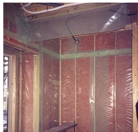
繊維系断熱材など透湿抵抗の小さい断熱材を使う時は、防湿層にJIS適合の防湿フィルム使用が義務付けられたが、一方で厚さは問わなくなった
