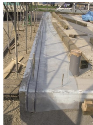
基礎断熱でパッキン付き先張りシートを基礎天端に施工している現場。この後土台を敷いて最終的に外壁の防湿・気密シートと連続させる
