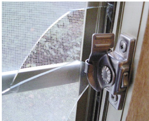
空き巣に割られた窓ガラス。ユーザーの命と財産を守るには、よりいっそうの防犯・防災対策が必要になる
