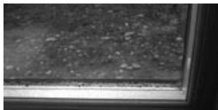
写真1・新築直後の住宅は、工事水が抜けきれていないため窓に結露しやすい
