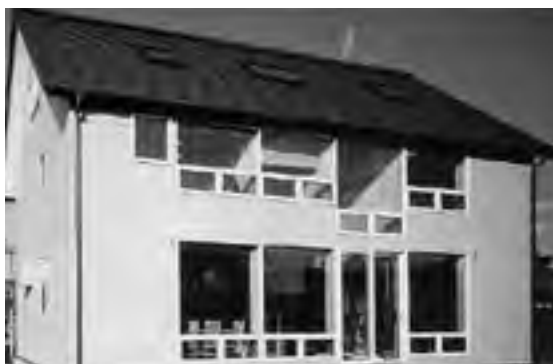
北海道で建てられたエコハウスの南面。極端にガラス面が広いわけではないが、サッシを柱の外側に付けることでガラス面積が通常の取り付けより15%広がっている
