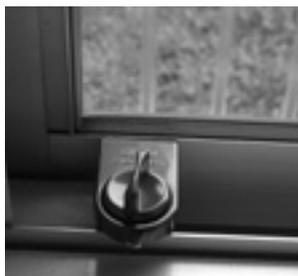
写真2・サッシを固定するロック金具
