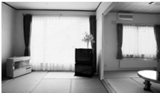
写真2・温水ボイラー付FFストーブで左の部屋を高温の輻射熱で暖房し、温水パネルで右の部屋を暖房している例
