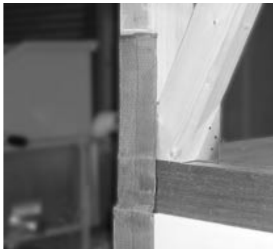
アラミド繊維シートを基礎・土台・柱それぞれにかかるように張って補強した施工例
