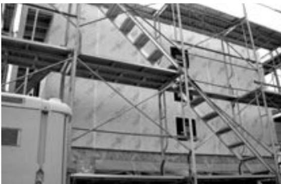
高性能フェノールフォームを断熱材に使用している現場。公庫仕様書の断熱性能区分は最高のFランクなので、北海道でも58mmの厚さで次世代省エネ基準をクリアできる
