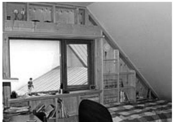
外断熱で柱間の空間を棚として有効利用している例
