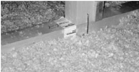
施工現場で施工厚を検査するためのスケール
