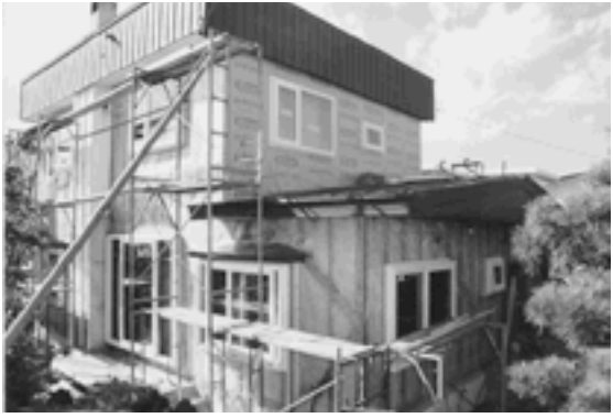
軸間断熱の築23年の住宅を外断熱で改修している事例
