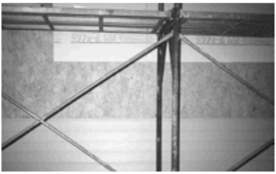
既存の外装材の上に押出スチレンボードとロックウールボードを付加し、樹脂製サイディングで仕上げている住宅
