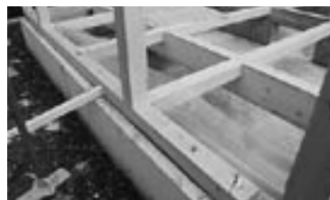
写真1・外側断熱の施工例
