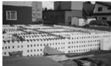
写真2・かんたんベースの施工例
