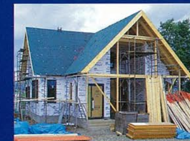
防風シートを貼り外壁仕上げに施工に入ります
