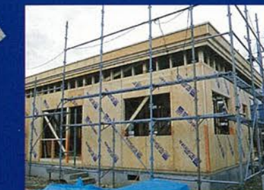
壁パネルの施工が終了した状況
