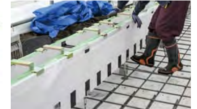
外周部室内側の断熱型枠は200mmの土間厚さ分だけ浮かせている
