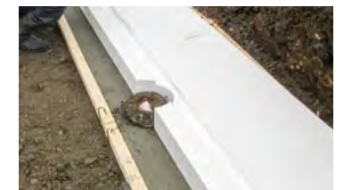
実証施工では杭頭の露出する部分にあわせて土間下断熱材をくりぬいている
