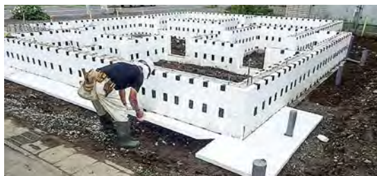
スカート断熱工法の施工現場。基礎外周部の地盤を水平断熱している
