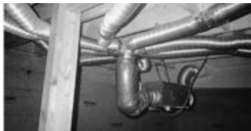
写真1・チャンバー方式採用の換気システム
