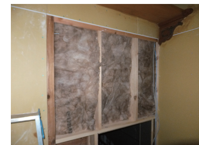
軸間に充填されたグラスウール100mm
