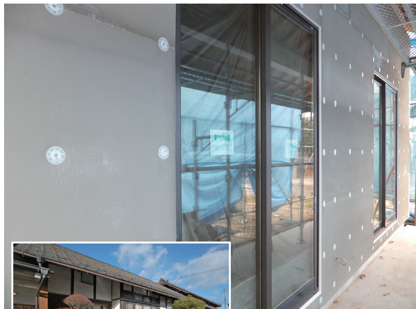
古民家の外壁に使われたDAN壁。断熱厚は70mmで、軸間充填のグラスウール100mmと併せて170mm断熱となっている。左の写真は改修前の外観
