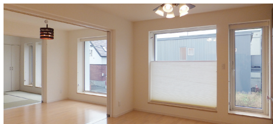
樹脂サッシに Low-E トリプルガラスを組み合わせ、断熱性を高めつつ日射を多く取りこめる大開口とした北海道の住宅
