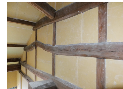
梁の曲がりに合わせてロフトとなる小屋裏間仕切り壁の石膏ボードを丁寧にカット
