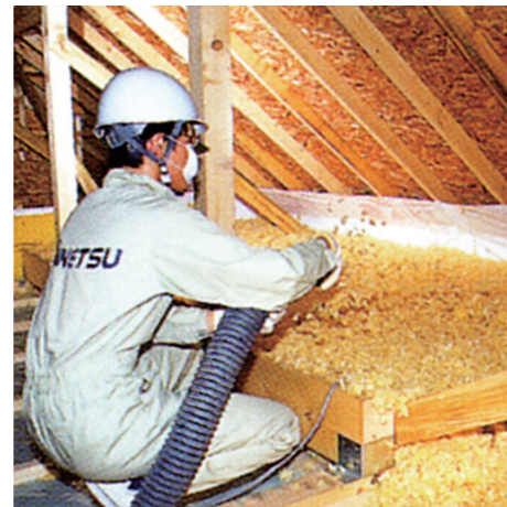
ブローイングは確かな施工品質で、関東でも天井断熱の標準工法となるよう引き続き力を入れていく
