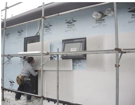
30周年を機に、省エネ改修事業などを通じて「そとだんパネル」の魅力を積極的に発信していく（写真は新築時の施工の様子）
