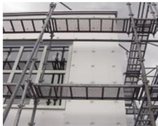
そとだんパネルはビスが構造体にしっかり効くよう、ワッシャーが当たる部分を20mm座掘りした。この後、座掘り部分にはEPS製のキャップをはめて断熱欠損を防いでいる
