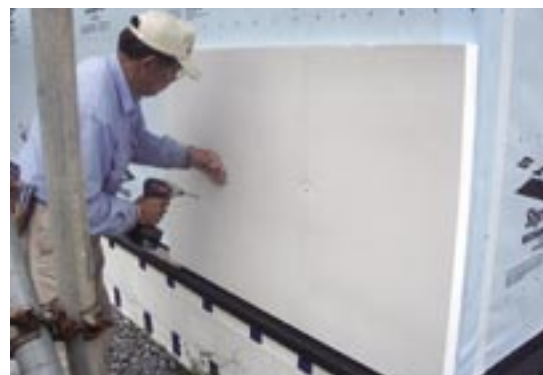
SOTOdanパネルをビスとワッシャーで留めているところ。3×6尺サイズを横使いで千鳥状に施工していく
