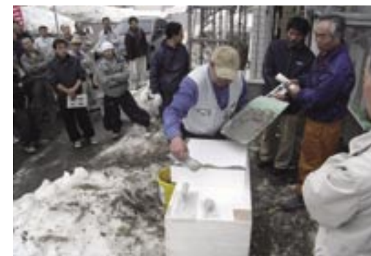
実証棟で行われた施工研修では、43名の職人が実際にベースコートやトップコートの施工を行った
