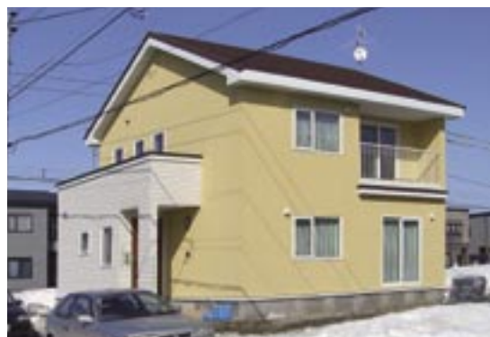
落ち着いたカラーとテクスチャーで仕上げた実証棟の外観
