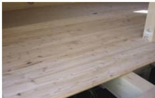
無垢材のフローリングと自然塗料の組み合わせは健康住宅の定番だが、自然塗料でも乾燥過程で微量なホルムアルデヒドを放散する可能性があることに注意しておきたい
