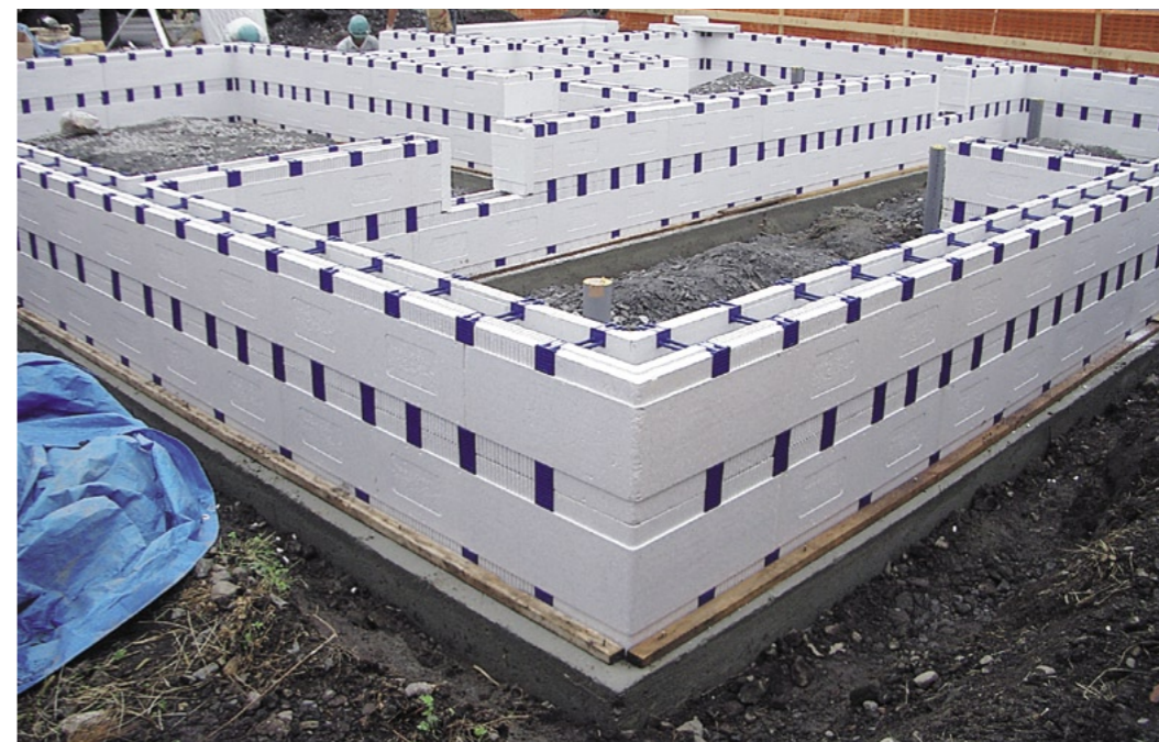
型枠断熱材の厚さを 53 mm から 65 mm に増やした「かんたんベース」の施工現場
