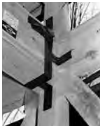
写真1・スリーブ付きの気密補助部材を使った梁廻り
