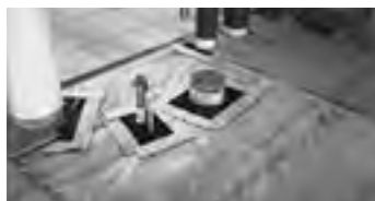
写真2・専用ラバーで気密化した床の配管廻り
