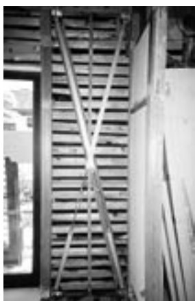
トステムホームウエルが発売している耐震補強用金属製筋交い
